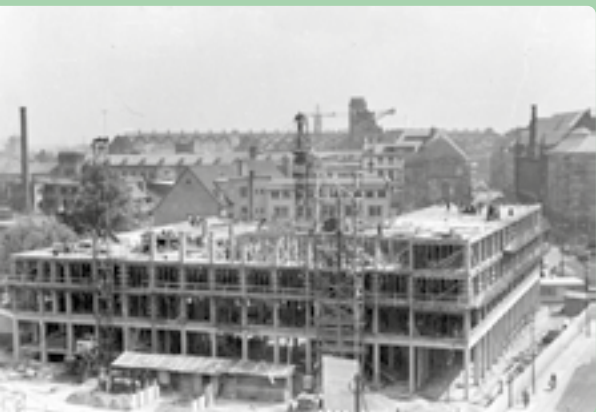
Im Herbst 1950 begannen die Arbeiten für das IHK-Gebäude am Börsenplatz.
