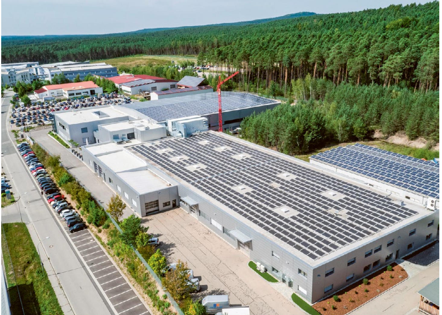
An sonnigen Tagen produziert eine PV-Anlage auf dem Firmendach der SK Technology GmbH in Roding, das mit einem Blockheizkraftwerk und der Energierückgewinnung der Maschinen gekoppelt ist, zwei Drittel des Strombedarfs. (Firmenfoto)
