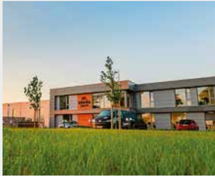
Die moderne Zentrale von steda in Meppen-Versen liegt unmittelbar an der E 233.
