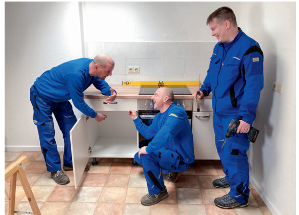
Teamleiter Dirk Weigel (Mitte) mit Sven Meyer (links) und Tobias Töpfer (rechts) beim Einbau einer Küchenzeile. Beide sind seit mehreren Monaten über das Förderprogramm in der TAG Immobilien Service GmbH.
