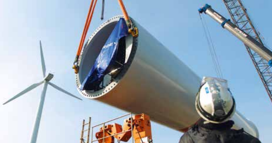
Aufbau einer Windkraftanlage im Kreis Nordfriesland
