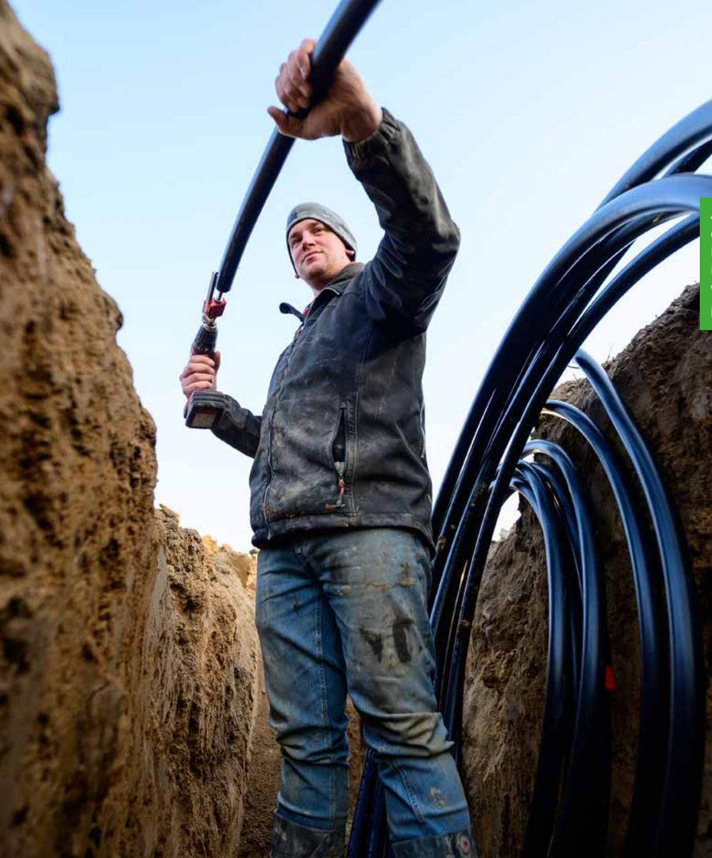
Avacon-Bauleiter Maikel Hahn in einem der 184 Bohrlöcher. Nach Fertigstellung wird Wärme aus dem Untergrund aufgenommen und zur Wärmepumpe in die Häuser transportiert.
