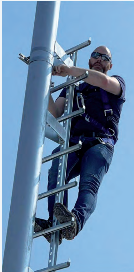
Montage einer 5G Antenne durch TELEPORT
