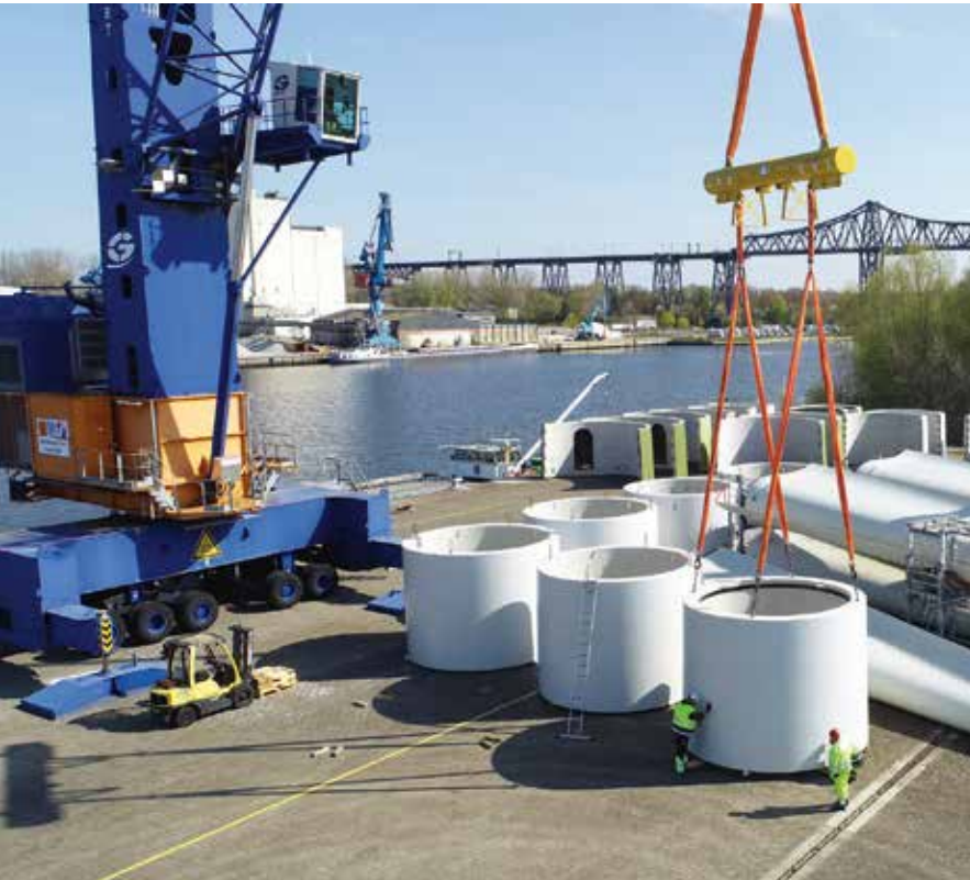
Arbeiter lagern Betonsegmente im Rendsburger Hafen ein.
