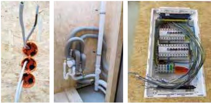
Installationen für Strom und Wasser sind ein Produktionsschritt, der bereits vor dem Aufbau auf der Baustelle erfolgt.
