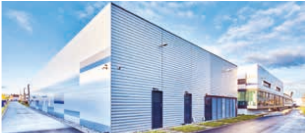
Firma Aero Pump GmbH in Hochheim
