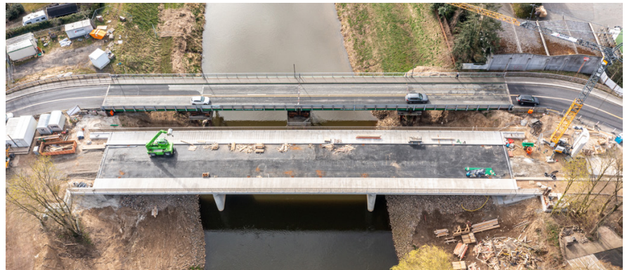
Behelfsbrücke Lingen-Schepsdorf im Verlauf der L 60
