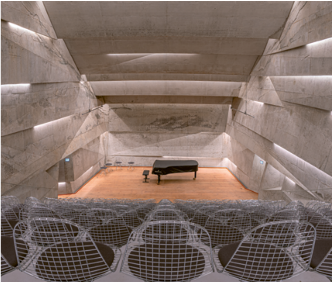
Aufgefaltete Betonstrukturen und unter den Sitzbänken versteckte Schallabsorber optimieren den Raumklang im 200 Zuhörer fassenden Kammermusiksaal des Konzerthauses Blaibach. (Foto: Michael Ettl)
