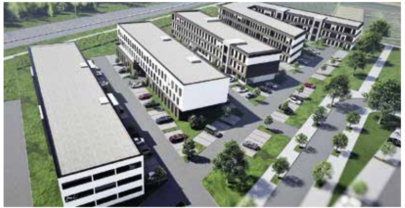
Im Limburger ICE-Gebiet entstehen in vier Gebäuden neue Büro- und Gewerberäume.
