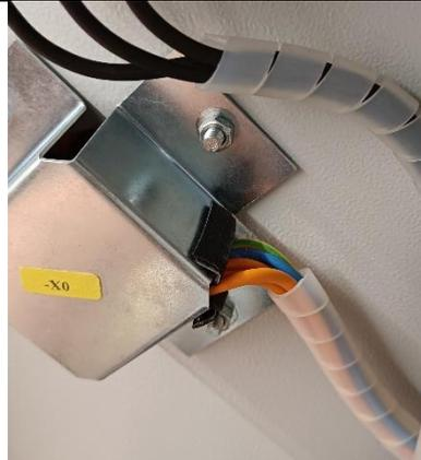
Metallteile sollten an den Schutzleiter angeschlossen werden und ein Kantenschutz ist zu verwenden.
