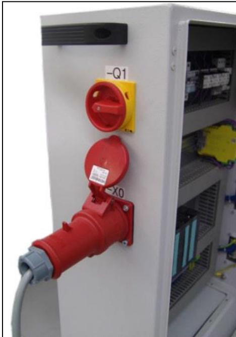
Zwischen dem Anschlussstecker –X0 und dem Hauptschalter –Q1 sollte der Abstand so groß gewählt werden, dass der Deckel des Anschlusssteckers den Schalter nicht überdeckt.
