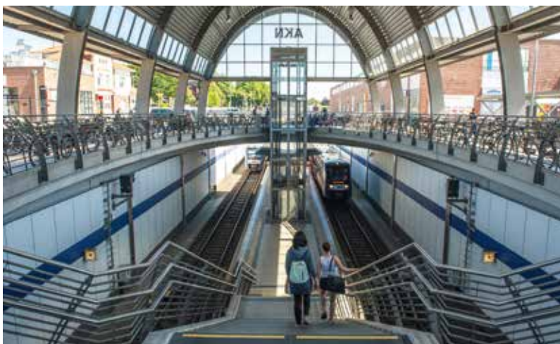
Bahnhof in Kaltenkirchen
