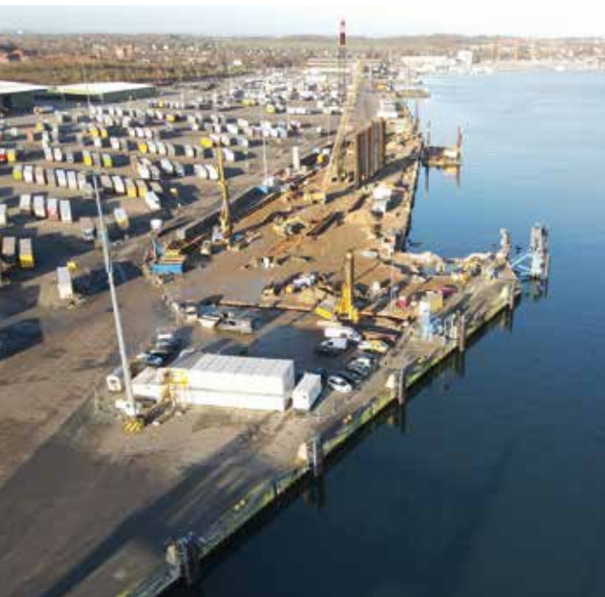
Blick auf den Skandinavienkai und die Baustelle des neuen Anlegers
