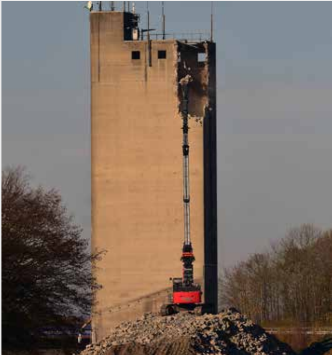
Stück für Stück wurde der Stahlbetonturm Ende 2021 zurückgebaut.
