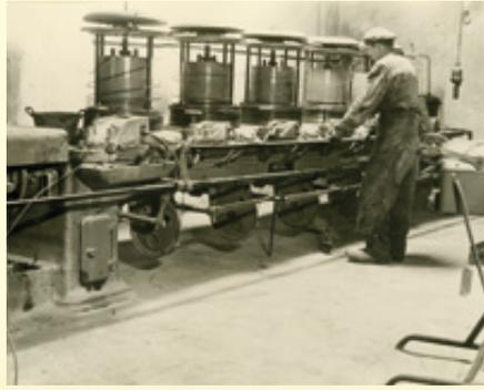
Mehrfachdrahtzug bei der Firma Gustav Stahlschmidt, Altena, um 1950
