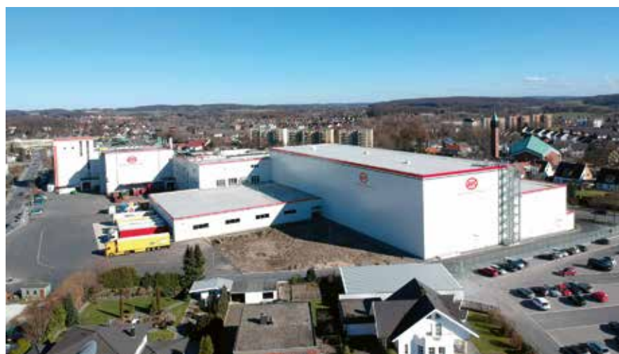
Der 2020 fertiggestellte Erweiterungsbau mit dem neuen Logistikzentrum beherbergt ein vollautomatisiertes Hochregallager mit 15.000 Palettenstellplätzen zuzüglich weiterer Stellplätze für 4.100 Lebensmittelcontainer sowie 14.000 Stapelbehälter für kühlpflichtige Produkte.
