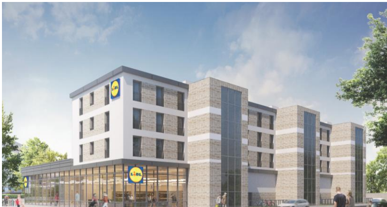
Berlin, Hönowestr. – Modulare Bauweise
