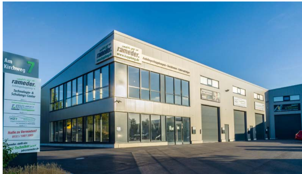
Neues Firmengebäude in Saalfeld: Büros, Schulungszentrum, Werkstätten
