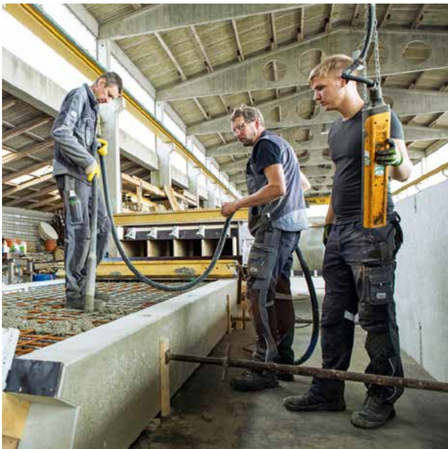
Mitarbeiter von Fritz Witt Betonwerke produzieren im Fertigteilwerk in Weddingstedt eine Betontreppe
