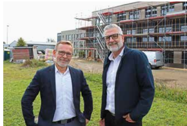
Kay Kruse und Dirk Dohmann (rechts) von MPF vor der Baustelle des Neubaus
