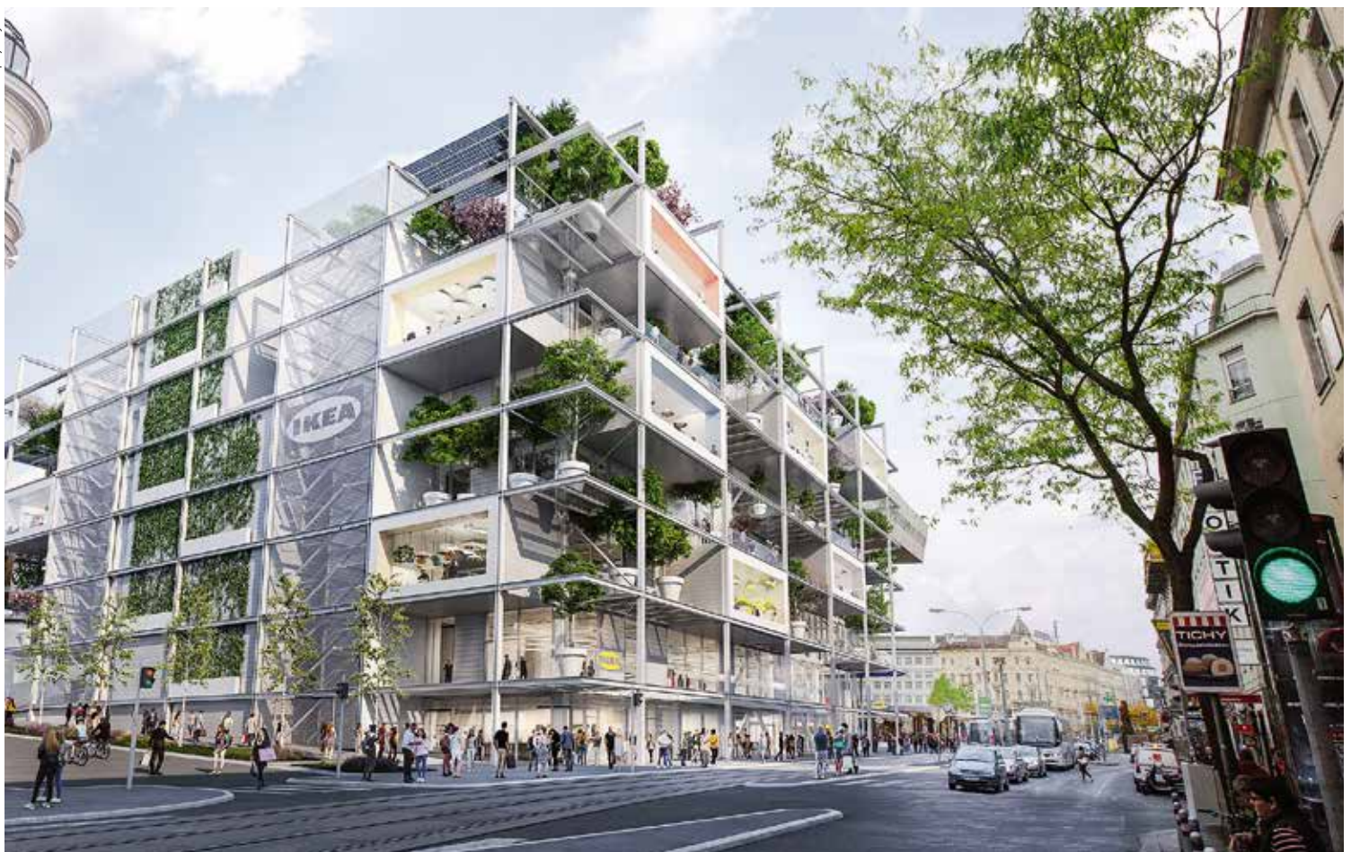
Bei der Ausgestaltung wirkten die Menschen aus dem Viertel mit: Ende August eröffnete der autofreie Ikea am Wiener Westbahnhof mit Snackbar auf der Dachterrasse.
