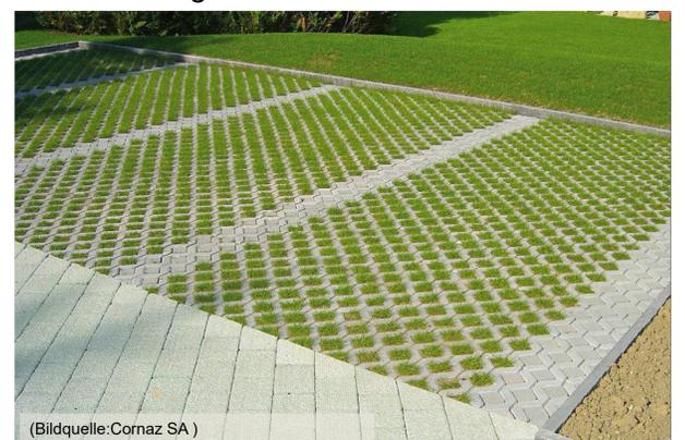
Abbildung 6: Anwendung von sickerfähigen Bodenbelägen
