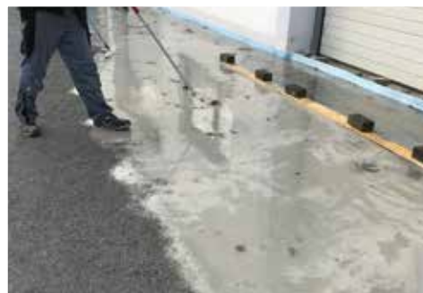
Innovativ: Kernstück des IB Stahls ist ein Teppich aus Stahldrahtfasern mit fließfähigem Hochleistungsinfiltriermörtel (kl. Bild).
