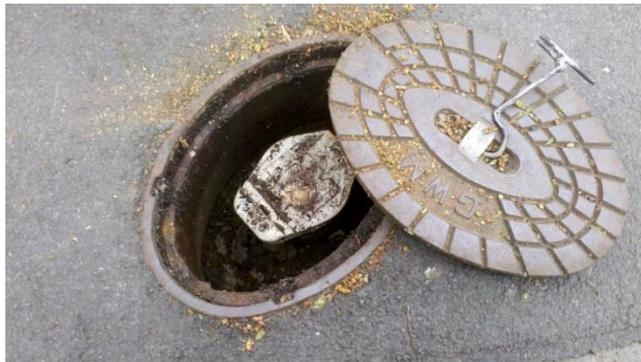
Abb. 15: Grundwassermessstelle in der Straßendecke
