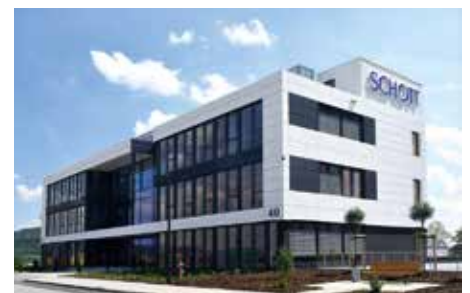
Referenzobjekt: SCHOTT JENAer Glas GmbH, Jena
