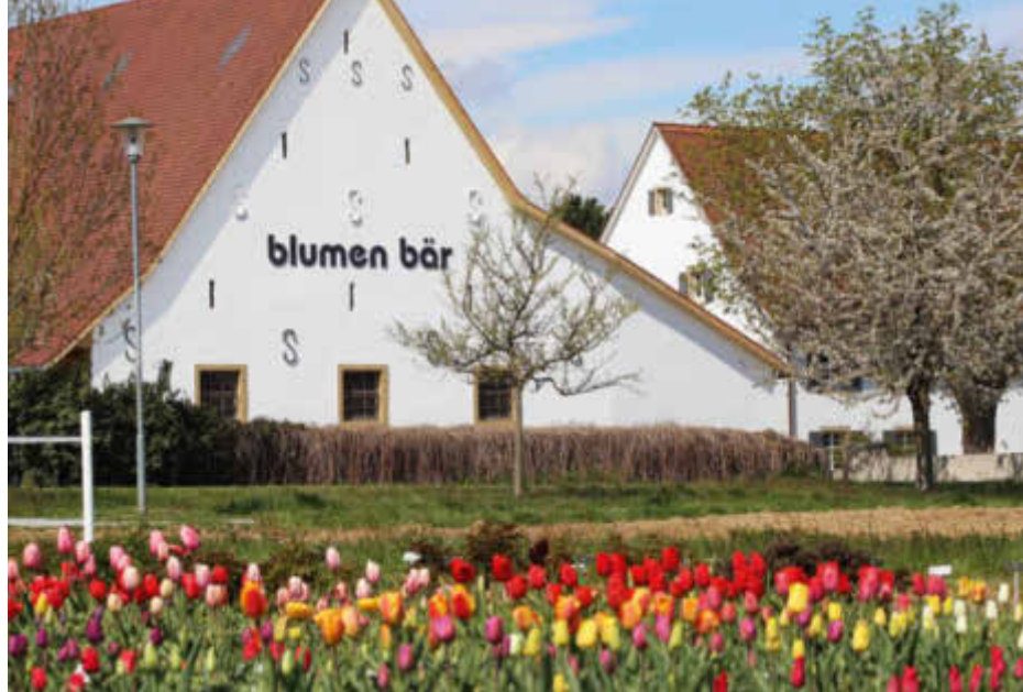
Dieses denkmalgeschützte Hofgut in Bad Krozingen hat Blumen Bär saniert und zum Firmensitz umgebaut.
