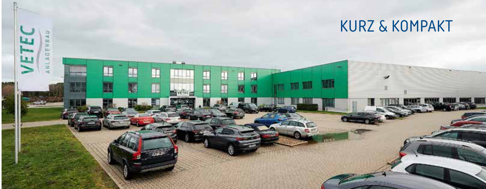
Fotos (2): VETEC Anlagenbau
