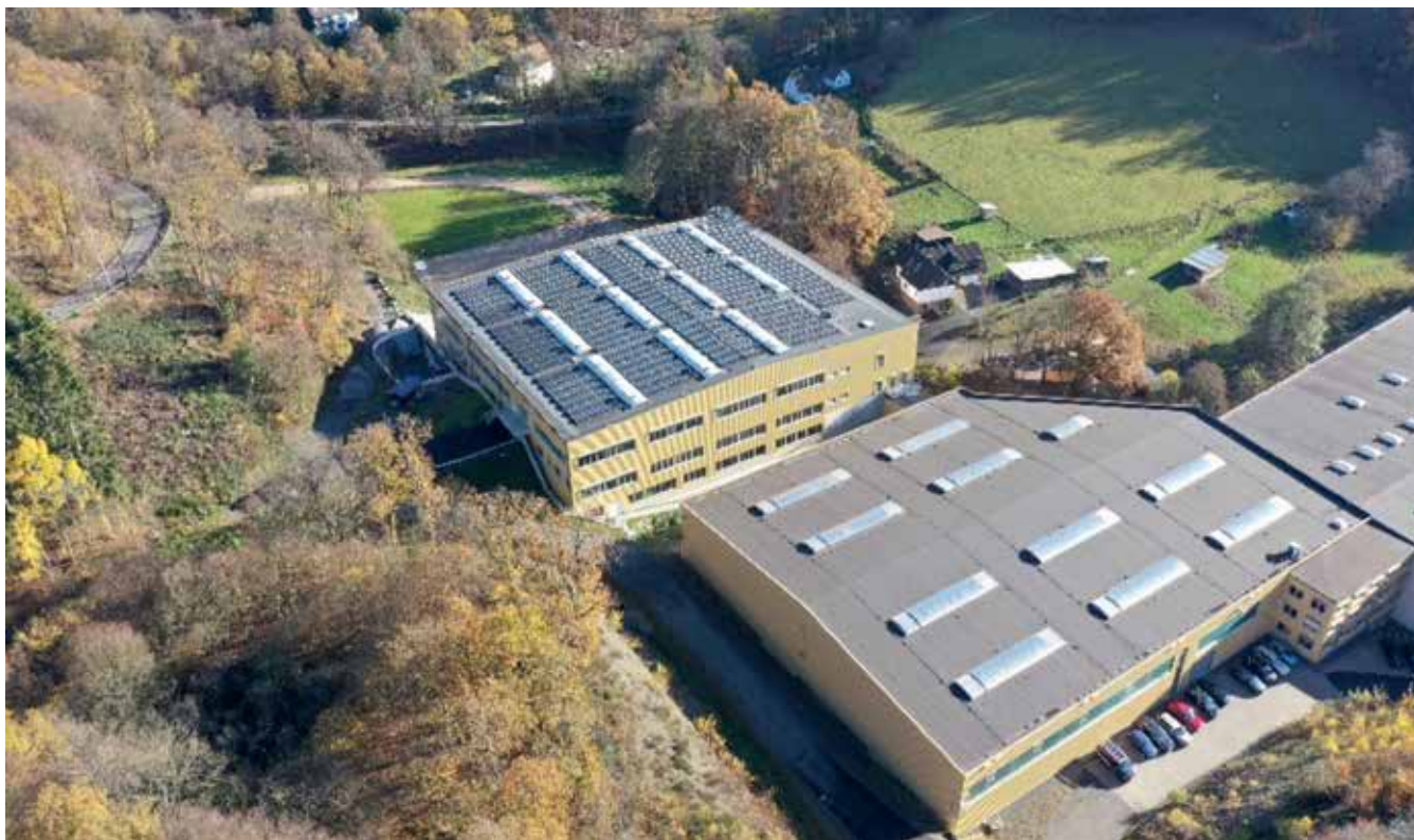
Abbildung 11: Aufsicht und Innenansicht (während der Bauphase) der neuen Halle der Fa. Elektrisola in Reichshof
