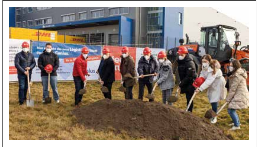
Hoch motiviert am neuen Bauprojekt, das rechts an die bestehende Halle grenzt: Die Architekten Werner und Luca Blätzel, Sven Rückert und Klaus Marder (Riedel Bau), Bürgermeister Dr. Marius Hahn und die Bauherrenfamilie mit Cedomir, Petra, Mitja, Sabrina und Natalie Repac.
