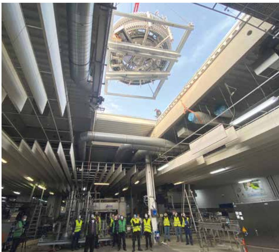
Am Haken eines Teleskopkrans wird die neue Abfüllanlage durch das Dach an seinen Platz manövriert
