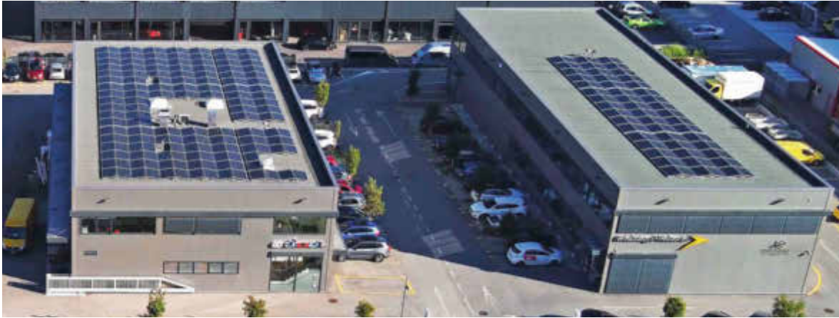
Eine der Photovoltaikanlagen, die Energiedienst vergangenes Jahr gebaut hat.
