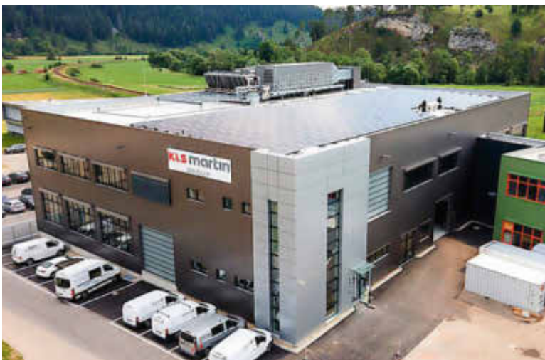
Im Juli 2020 hat KLS Martin sein „Gebäude 70“ in Mühlheim bezogen, das mit Kosten von 13 Millionen Euro die bislang größte Einzelinvestition ist.
