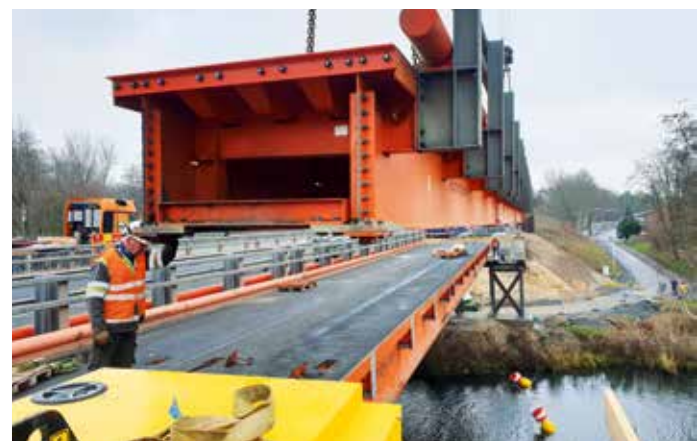
Bild oben: Bagger bei der Herstellung einer Lagerfläche im Rahmen der vorbereitenden Arbeiten für den B-5-Ausbau; links: Ein Brutkasten wird als Ausgleichsmaßnahme auf Fehmarn angebracht; rechts: Montage der Behelfsbrücke über die Eider.
