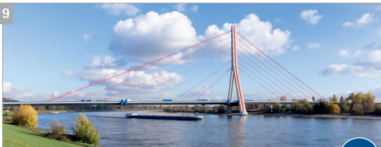
Fleher Brücke (Baujahr 1979)
