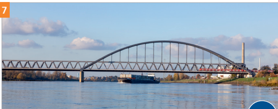
Hammer Eisenbahnbrücke (Baujahr 1987)
