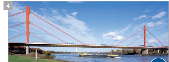
Beeckerwerther Brücke (Baujahr 1990)
