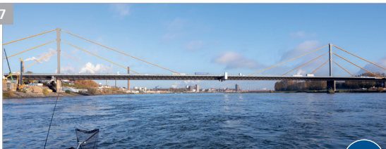
Rheinbrücke Neuenkamp (Baujahr 1970)
