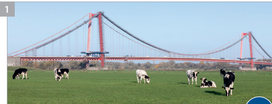
Rheinbrücke Emmerich (Baujahr 1963)
