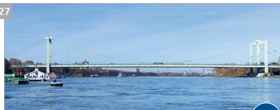
Rheinbrücke Köln-Rodenkirchen (Baujahr 1941)
