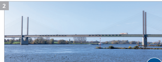
Rheinbrücke Rees-Kalkar (Baujahr 1967)
