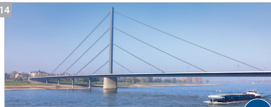
Oberkasseler Brücke (Baujahr 1976)
