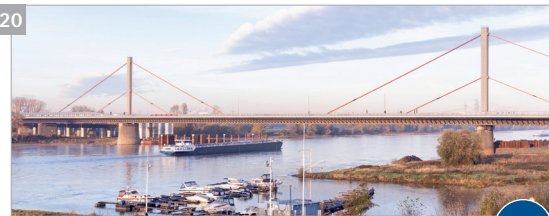
Rheinbrücke Leverkusen (Baujahr 1965)
