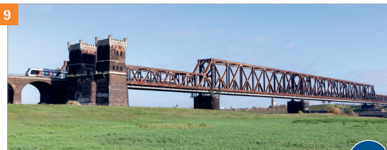
Duisburg-Hochfelder Eisenbahnbrücke (Baujahr 1949)
