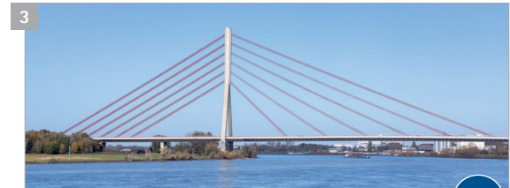
Niederrheinbrücke Wesel (Baujahr 2009)
