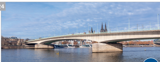
Deutzer Brücke (Baujahr 1948)
