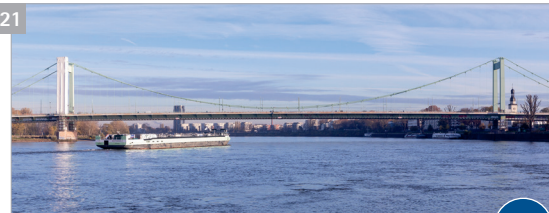
Mülheimer Brücke (Baujahr 1951)
