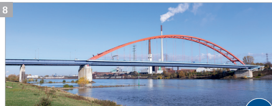
Brücke der Solidarität (Baujahr 1950)
