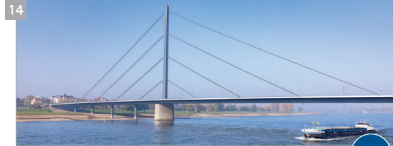
14 Oberkasseler Brücke (Baujahr 1976) 2,6 1 Stadt Düsseldorf 2 Landesstraße 392 3 17.000 Fahrzeuge, davon 300 Schwerlastverkehr 4 keine
