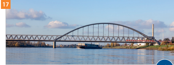
17 Hammer Eisenbahnbrücke (Baujahr 1987)
