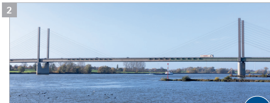
2 Rheinbrücke Rees-Kalkar (Baujahr 1967)
