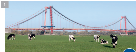
1 Rheinbrücke Emmerich (Baujahr 1963)
