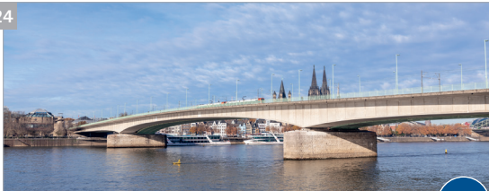
Deutzer Brücke (Baujahr 1948)
