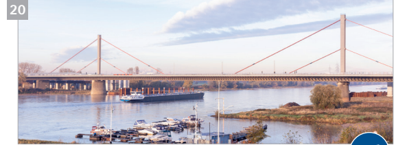
20 Rheinbrücke Leverkusen (Baujahr 1965)
