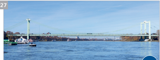
Rheinbrücke Köln-Rodenkirchen (Baujahr 1941)
