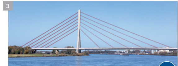
3 Niederrheinbrücke Wesel (Baujahr 2009)
