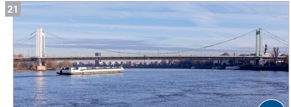
21 Mülheimer Brücke (Baujahr 1951)
