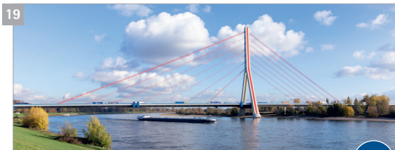
19 Fleher Brücke (Baujahr 1979)
