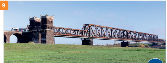
Duisburg-Hochfelder Eisenbahnbrücke (Baujahr 1949)
