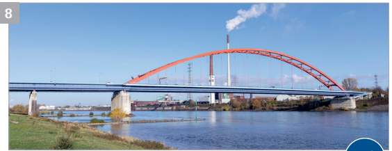
Brücke der Solidarität (Baujahr 1950)
