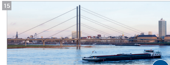
15 Rheinkniebrücke (Baujahr 1969) 2,8 1 Stadt Düsseldorf 2 kommunale Brücke 3 63.000 Fahrzeuge, davon 1.200 Schwerlastverkehr 4 Ablastung auf 30 Tonnen
