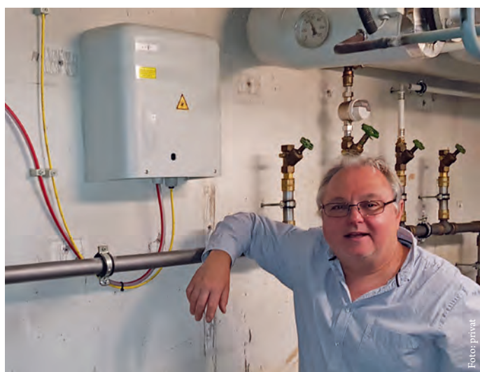
Thomas Bachert, Geschäftsführer der Bachert Datentechnik im Wetzlarer Gewerbegebiet Spilburg, hat schon seit einiger Zeit einen Glasfaseranschluss im Gebäude liegen – allerdings auf private Initiative hin. Nun kommt das schnelle Internet geballt in die Gewerbegebiete des Lahn-Dill-Kreises – der Zuwendungsbescheid vom Land liegt vor. Die IHK Lahn-Dill hat das Projekt in der Steuerungsgruppe „Lahn-Dill-Breitband“ engagiert mit vorangetrieben.
