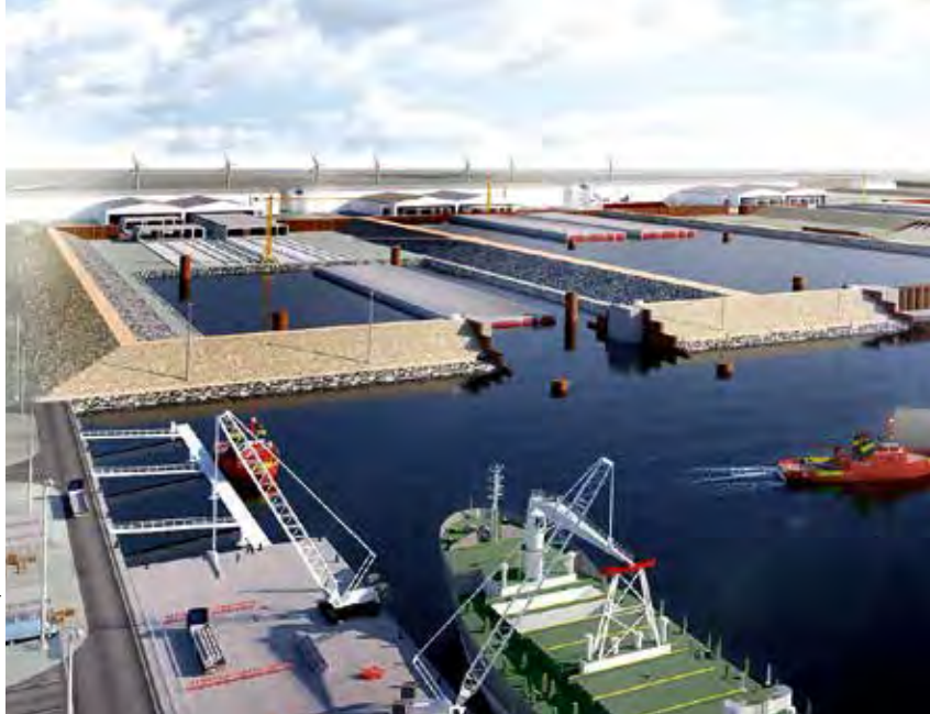
Visualisierung des Arbeitshafens und der Tunnelementfabrik
