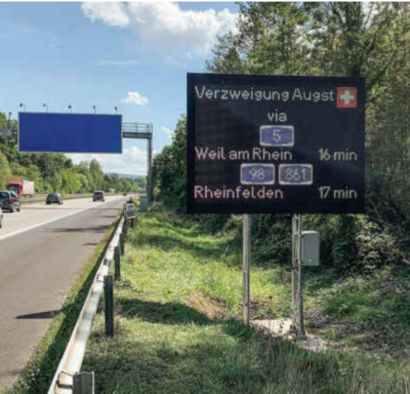
Vor dem Autobahndreieck Weil am Rhein an der A 5 zeigt die neue digitale Anzeigetafel die Reisezeit nach Augst über Basel und alternativ über Rheinfelden an.
