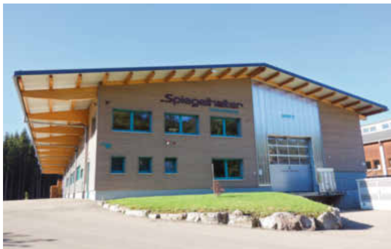
Das neue Werk 2 von Spiegelhalter.
