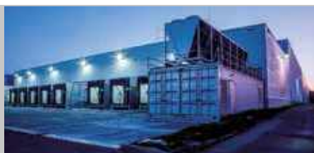
Kühlager ALDI Nord in Wilsdruff
