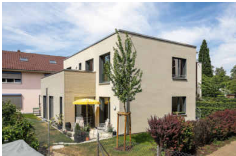
Neubauprojekt aus dem Jahr 2019: ein Erweiterungsbau in der Freiburger Quäkerstraße.
