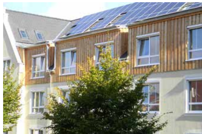
Einsatz von Vakuum-Isolationspaneelen: Altenpflegeheim Kreischa
