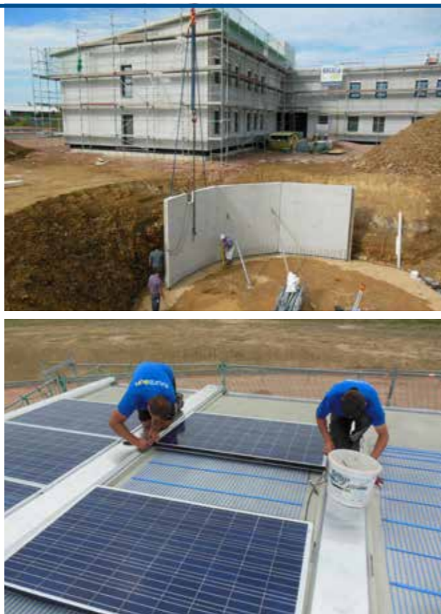
Neubau Firmenzentrale Hainichen
