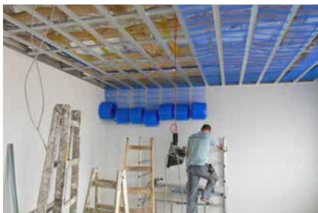
Montage Heiz- und Kühldecke
