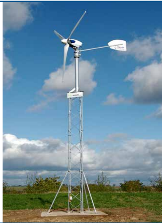
Heywind 5 kW im Allgäu, Masthöhe 12,50m, Baujahr 2011
