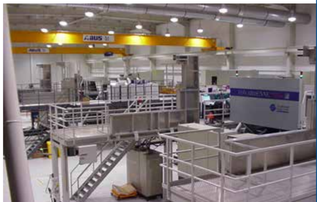
Blick in die Maschinenhalle
