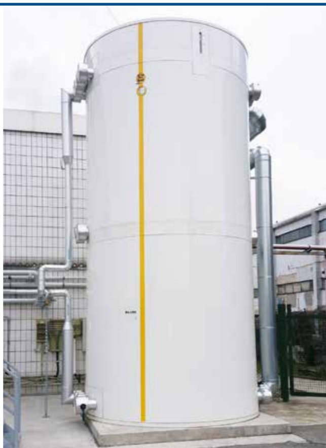
hocheffizienter Wärmespeicher aus GFK
