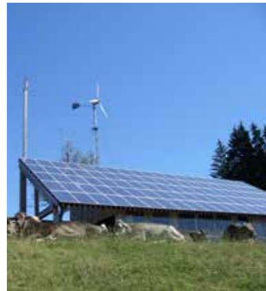
Heywind 5kW im Allgäu, Masthöhe 12,50m, Baujahr 2011
