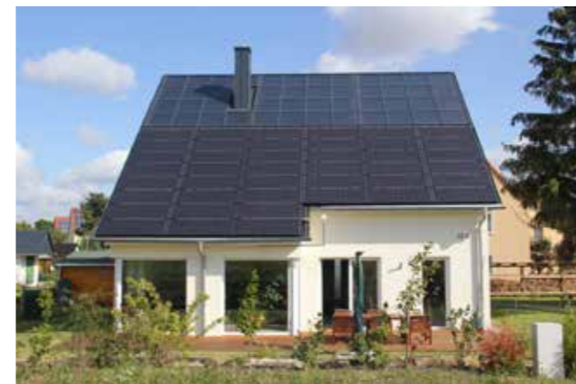
Eines der beiden Energieautarken Häuser von HELMA in Freiberg mit Photovoltaikanlage und Elektroenergiespeicher von SunStrom.
