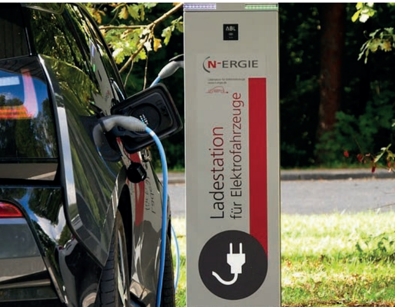
92 Ladestation für Elektrofahrzeuge
