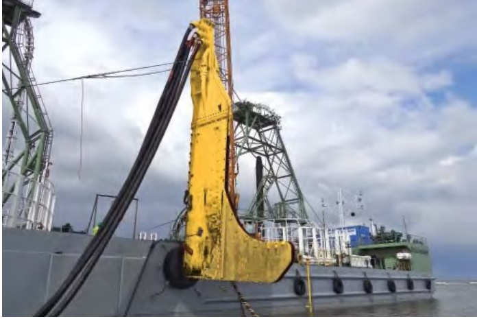
Mit dem Schwert wird das Kabel in den Boden eingespült.
