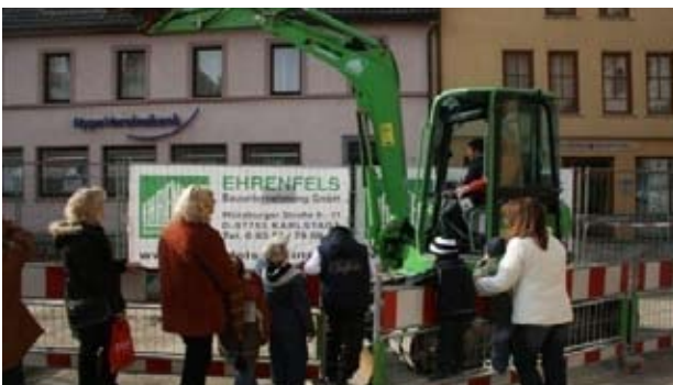
Baggern für Kinder, Karlstadt Foto: CIMA GmbH, 2008
