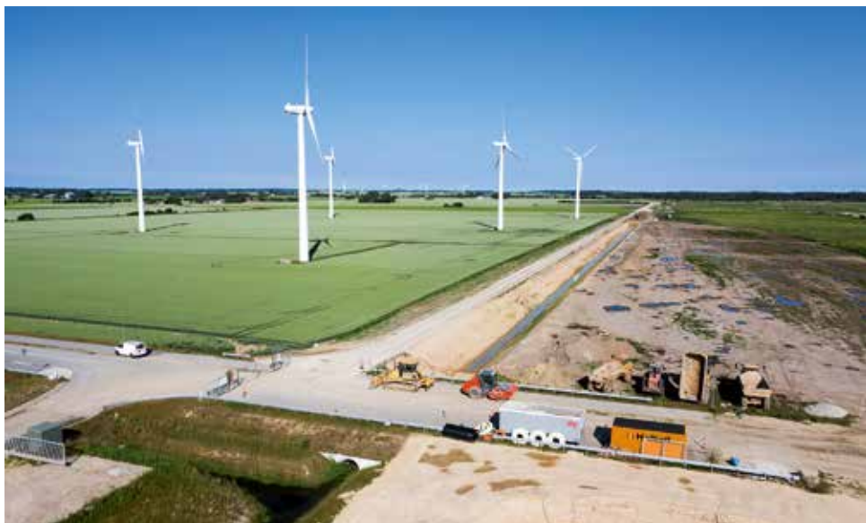
Erschließung der Tunnel-Baustelle in Rødbyhavn
