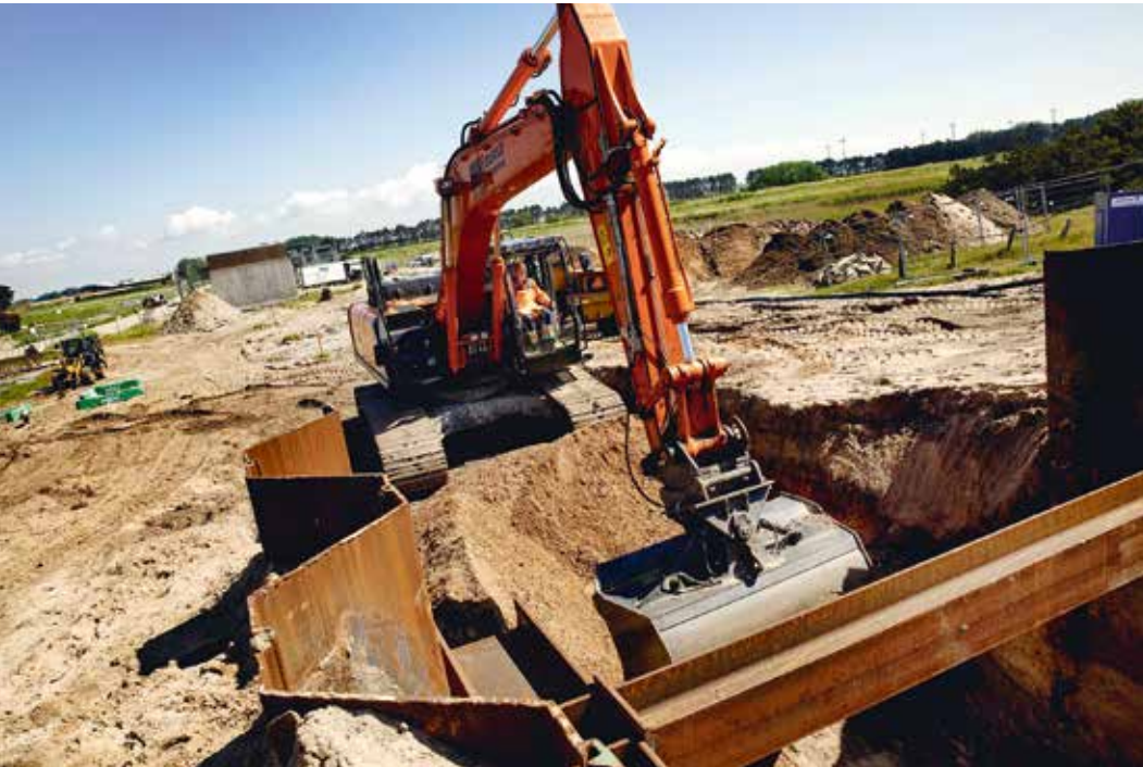
Auf dänischer Seite wird bereits gebaut: Das Foto zeigt Erdarbeiten für das Entwässerungssystem des Baustellenareals bei Rødbyhavn.
