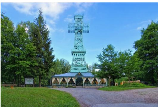
Das **Josephskreuz im Harz** ist ein Aussichtsturm auf der Josephshöhe des Großen Auerbergs bei Stolberg. Mit einer Höhe von 38 m und 200 Stufen trotz es mit 250 kg auf dem Quadratmeter jedem Orkan. Es ist das größte eiserne Doppelkreuz der Welt, mit einem Gewicht von 125 Tonnen und wird von ca. 100.000 Nietten zusammengehalten.
