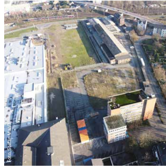
Die Dachflächen der Hallen sollen saniert und mit modernen Photovoltaik-Anlagen ausgestattet werden.
