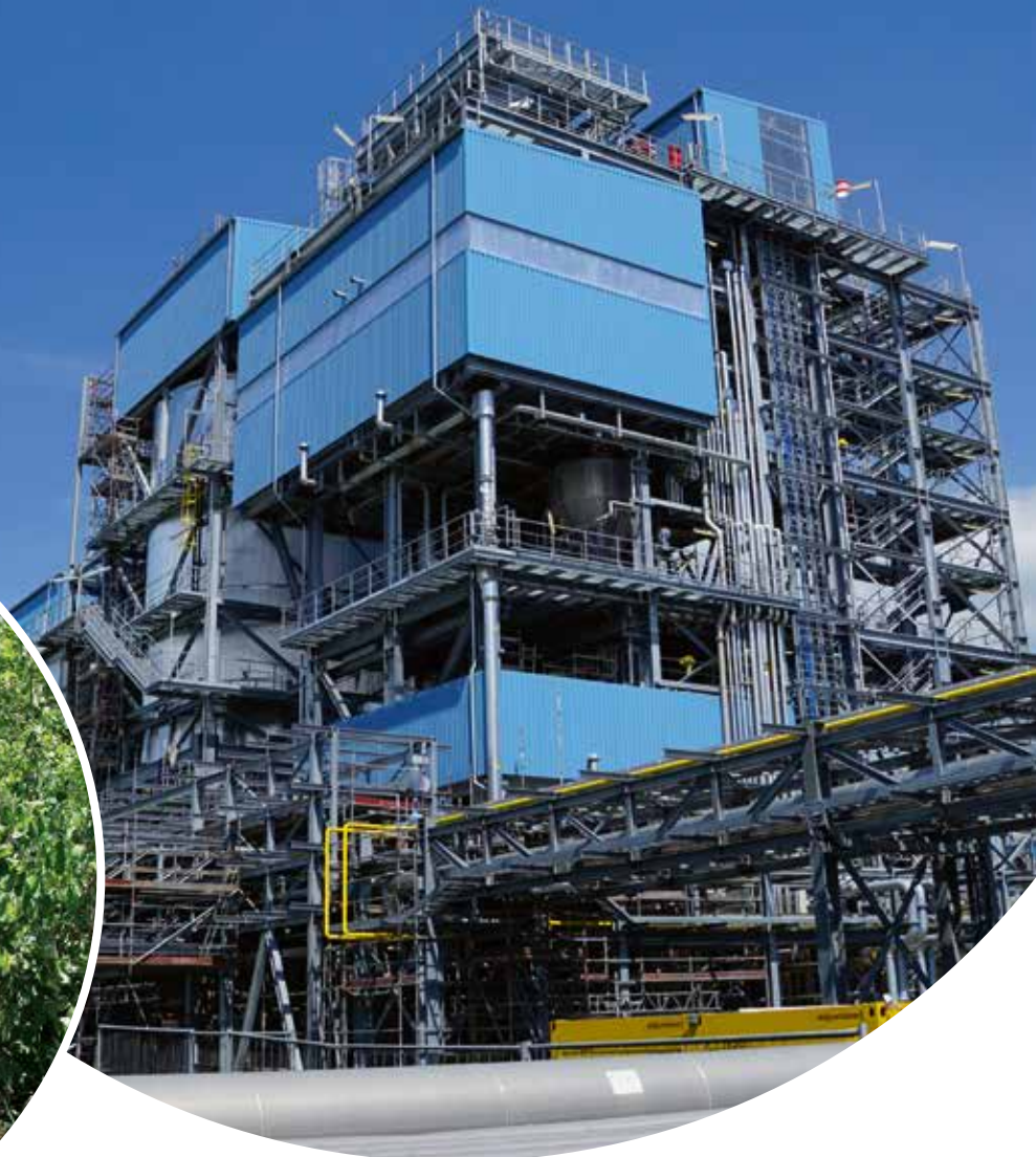
Bild oben: eine Trommeltrockneranlage bei Sasol in Brunsbüttel, in der spezielle Tonerdeprodukte getrocknet werden
